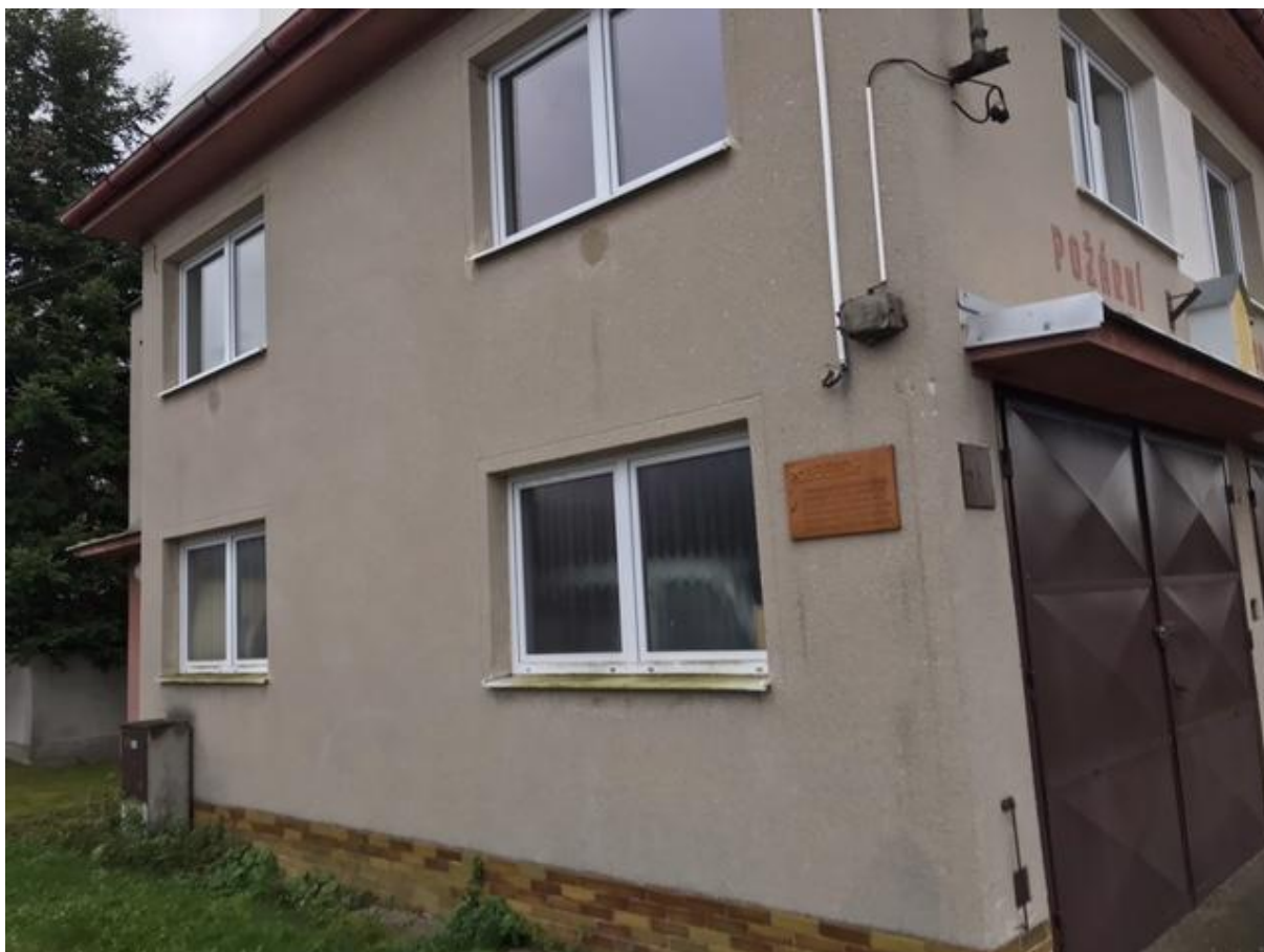
Obr. č. 1.4.5: Objekt hasičské zbrojnice
