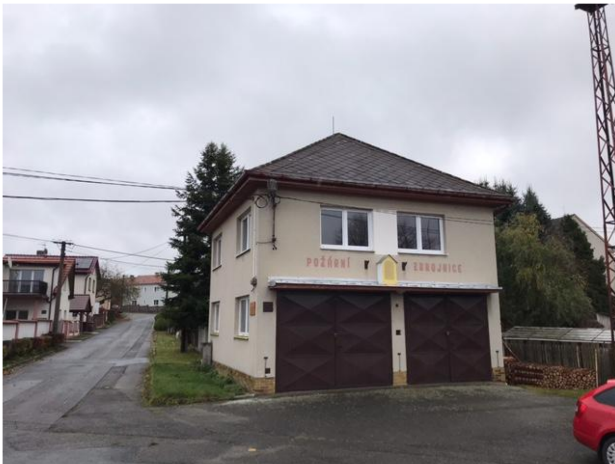
Obr č. 1.4.4: Objekt hasičské zbrojnice
