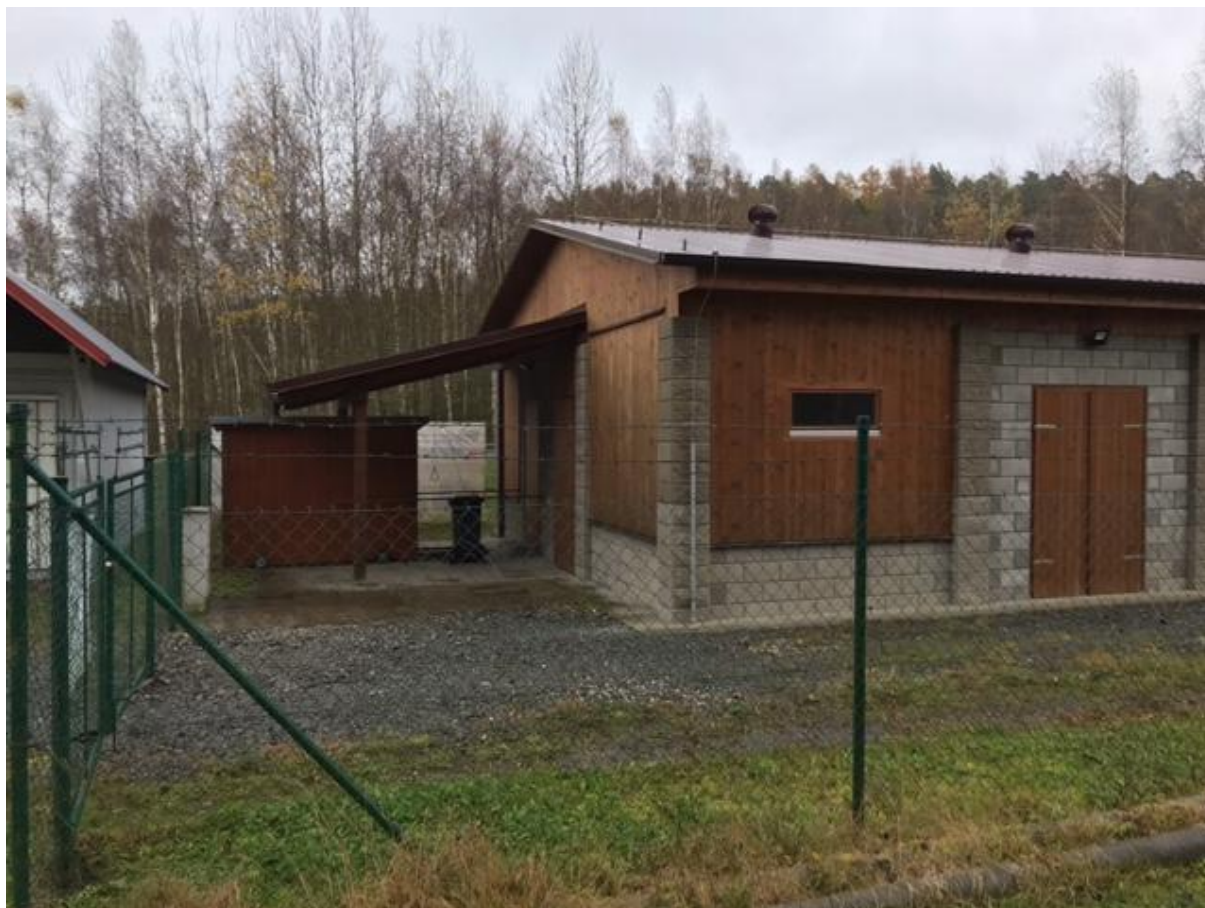
Obr. č. 1.4.8: Objekt čističky odpadních vod (ČOV)
