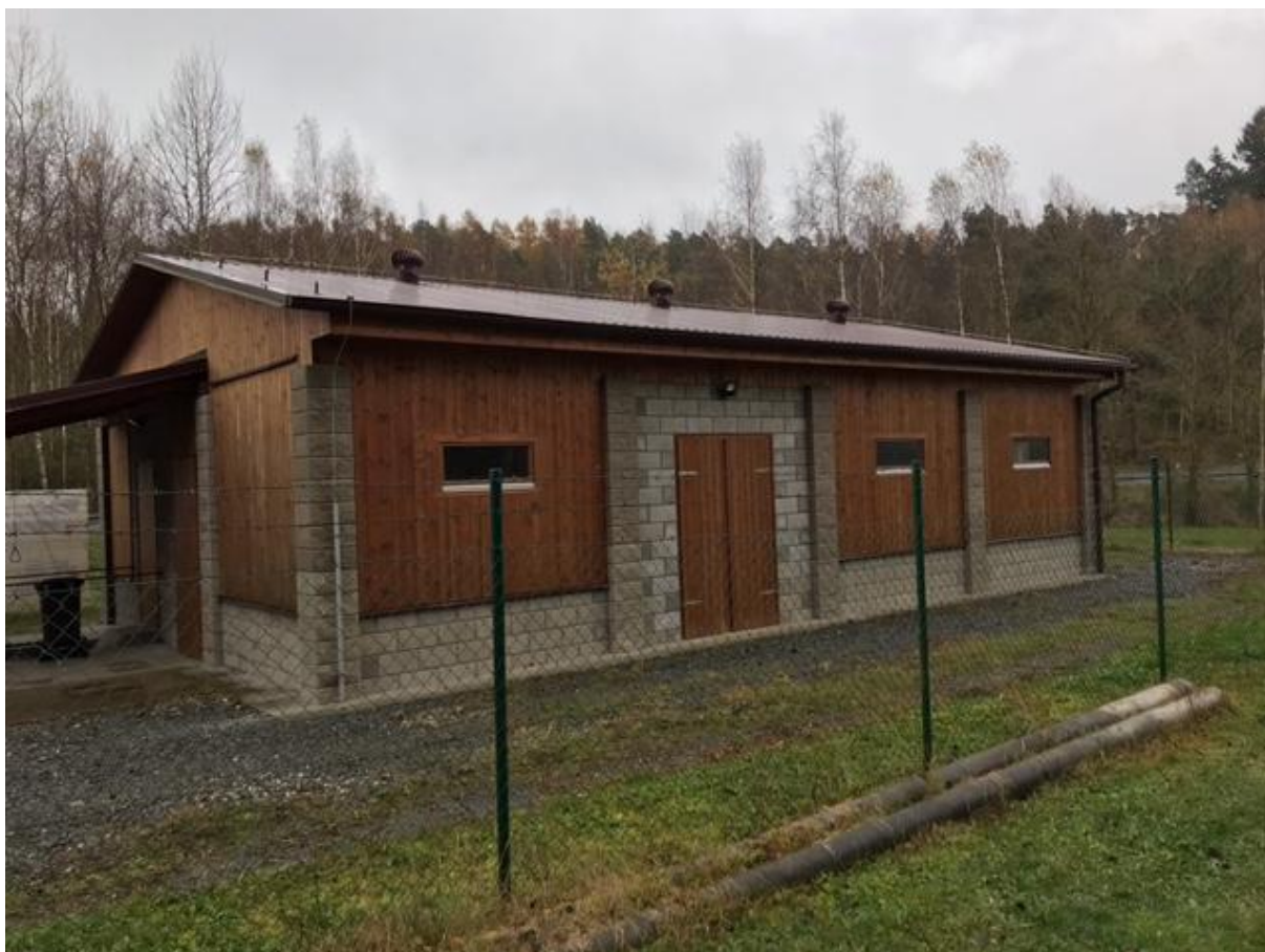
Obr. č. 1.4.9: Objekt čističky odpadních vod (ČOV)
