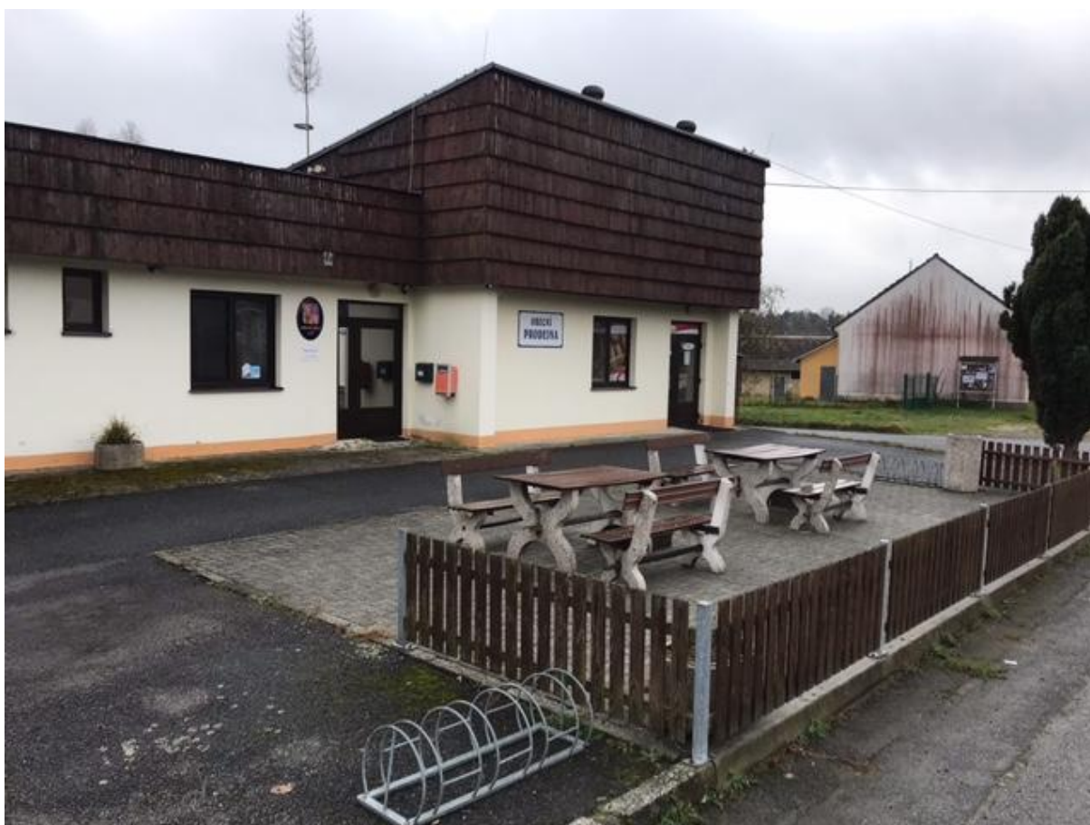
Obr. č. 1.4.2: Obecní budova – obecní obchod a obecní úřad
